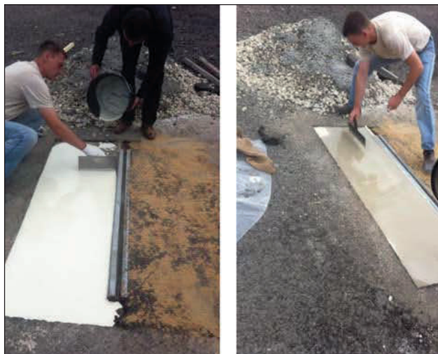
Рис. 6.2. Устройство переходной зоны из композитного материала «Matacryl WL»® фирмы «ТемпСтройСистема»
