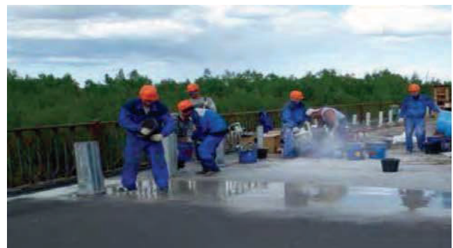
Наброска крошки для создания шероховатости
