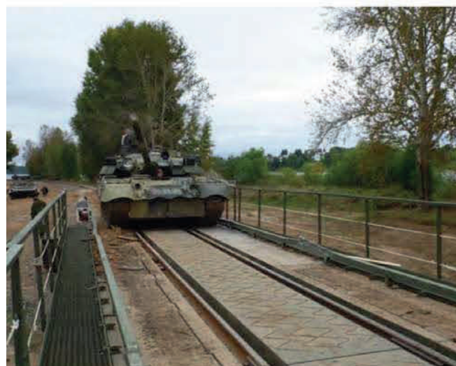
Устройство покрытия kolejных проходов на ИМЖ- 500 (сборный танковый и ж/д мост)
