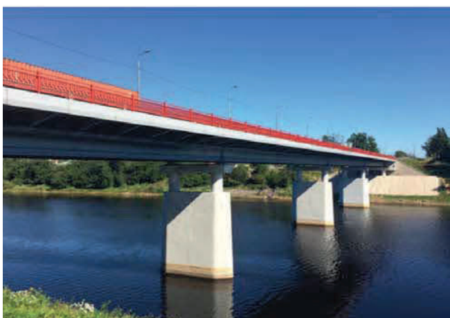
Устройство околошовных защитных ДШ на мосту ч/з реку Сясь, Ленинградская область
