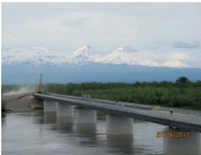
Устройство покрытия проезжей части, мост через р. Камчатка
