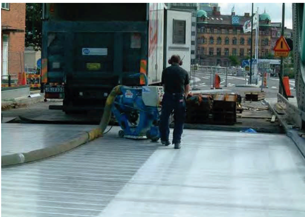
Рис. 1. – подготовка поверхности шлифовальными машинами с металлическими щетками, снабженными пылесосами.
