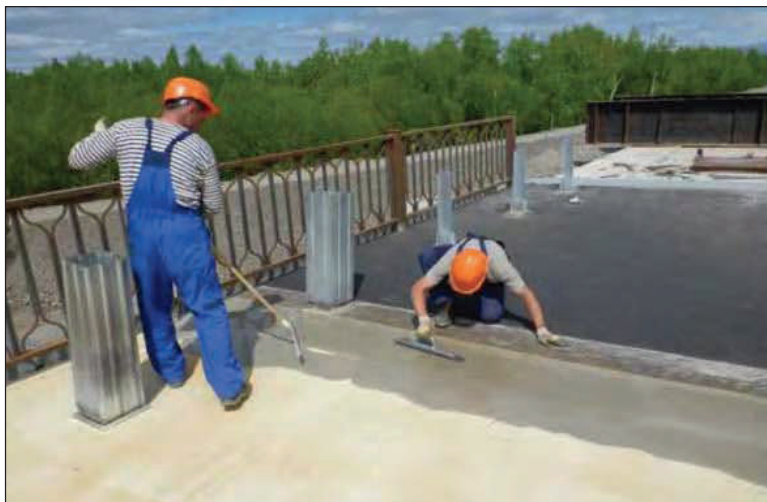
Рис.4. – нанесение основного износостойкого слоя «Matacryl WL»
