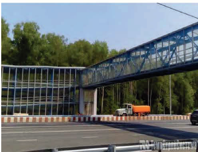
Устройство полимерного покрытия на мосту через ул. Орджоникидзе, г. Подольск, МО
