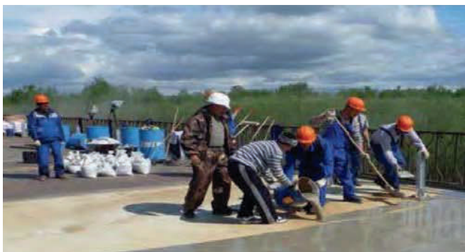
Нанесение основного износостойкого слоя
