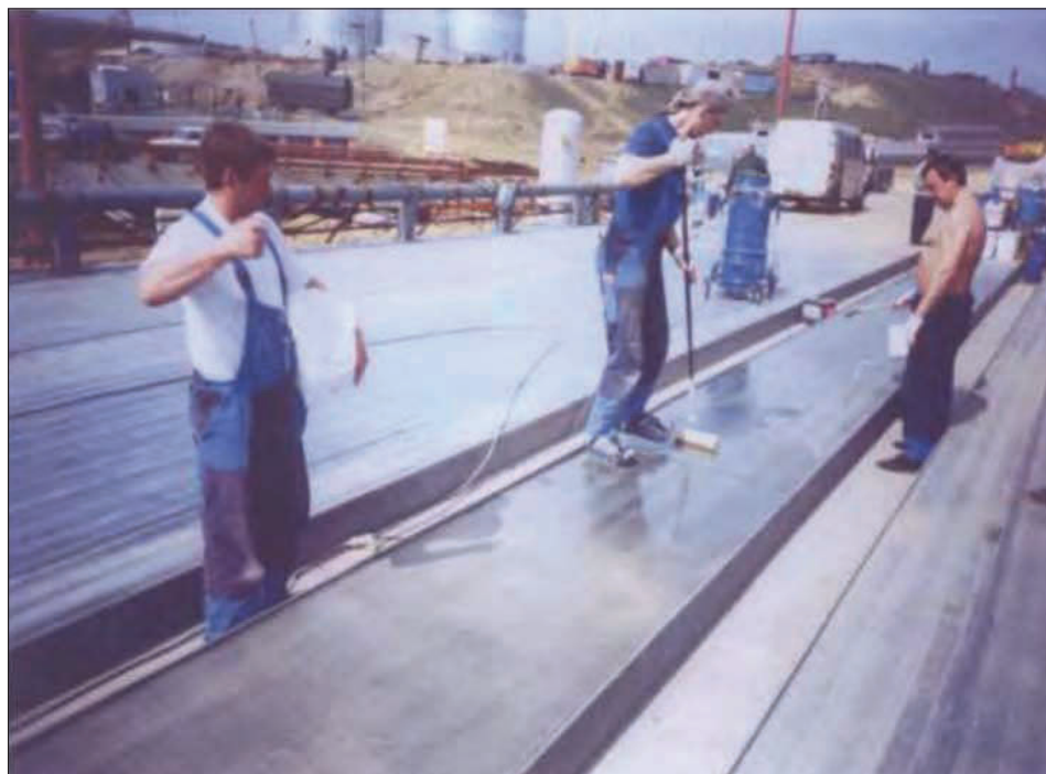
Рис 2. – нанесение праймера «Matacryl Primer CM®», присыпка песком.
