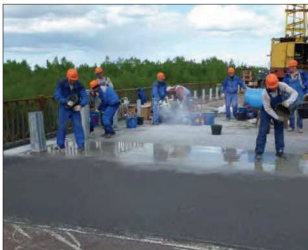
Рис.6. – на заднем плане нанесение основного износостойкого слоя «Matacryl WL», на переднем плане присыпка еще не полимеризовавшегося слоя корундом, работы идут одновременно.
