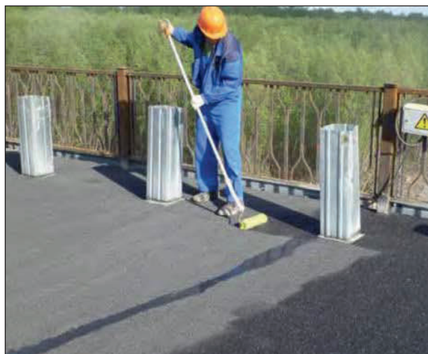
Рис. 7. – нанесение финишного лака «Matacryl STC»
