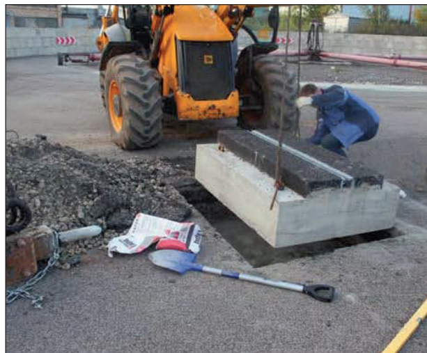
Рис. 6.3. Установка модели №2, с устроенными переходными зонами из ПУГМК
