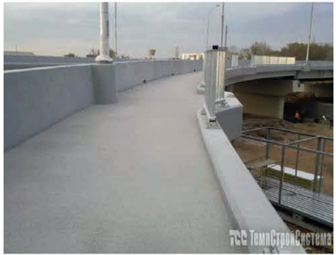
Устройство покрытия пешеходной зоны, | Звенигородский путепровод 3-ая Магистральная ул., Москва
