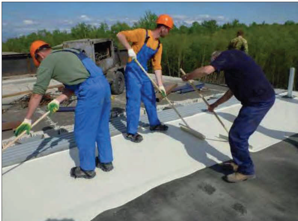
Рис.3. – нанесение демпфирующего слоя – мастики «Matacryl Manual®»
