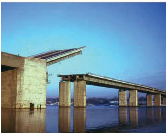
Устройство покрытия пешеходной зоны на разводном пролете, Ладожский мост, Санкт-Петербург
