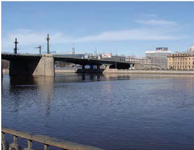
Устройство покрытия проезжей части Кантемировского моста, Санкт-Петербург
