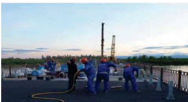
Удаление не сцепившейся крошки щетками и/или сжатым воздухом
