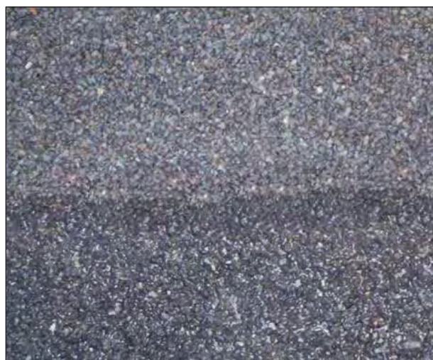
Рис.11. –сопряжение износостойкого слоя «Matacryl WL», присыпка гранитной крошкой (или аналогом), покрытие шва лаком «Matacryl STC». На рисунке изображен шов до покрытия финишным лаком. После нанесения лака «Matacryl STC» покрытие не имеет видимых швов.
