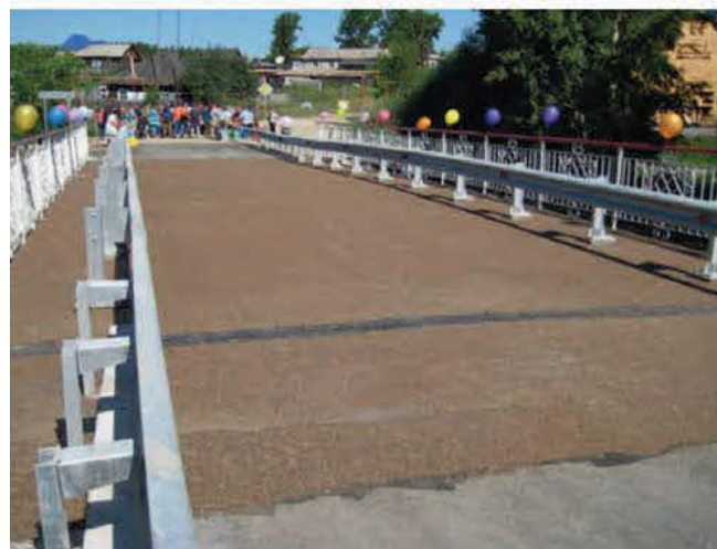
Полимерное покрытие моста через реку Пашенка, г. Новосибирск
