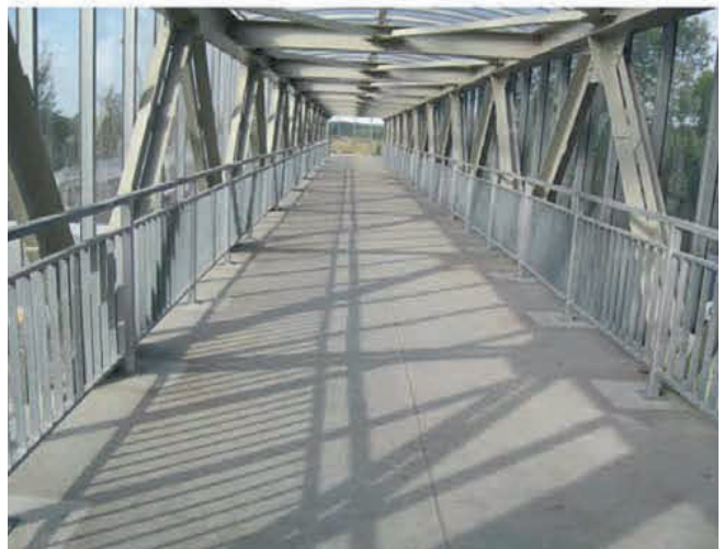
Устройство покрытия противоскольжения на пешеходном мосту, г. Тверь
