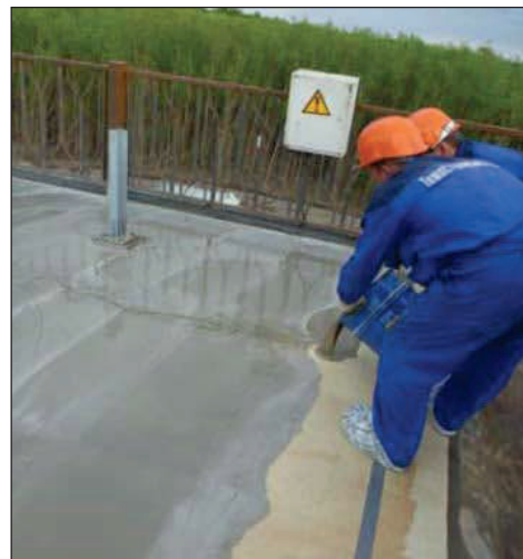
Рис.5. – нанесение основного износостойкого слоя «Matacryl WL»
