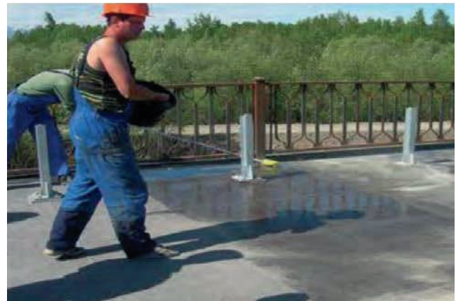
Нанесение грунтовочного слоя
