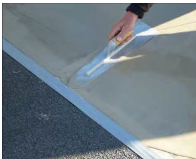
Рис.10. – сопряжение износостойкого слоя «Matacryl WL»
