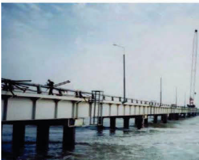
Устройство покрытия kolejных проходов, портовый терминал, Тамань
