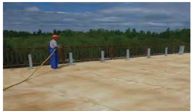
Нанесение грунтовочного слоя, присыпка песком
