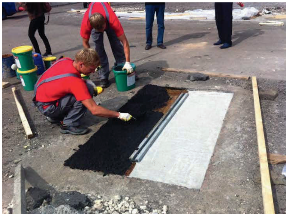
Рис. 6.1. Устройство переходных зон на модели №1:слева из холодного а/б; справа из полиметилметакрилата
