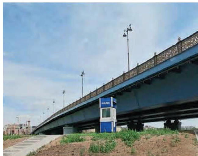
Полимерное покрытие моста через реку Ишим, г. Астана, Казахстан
