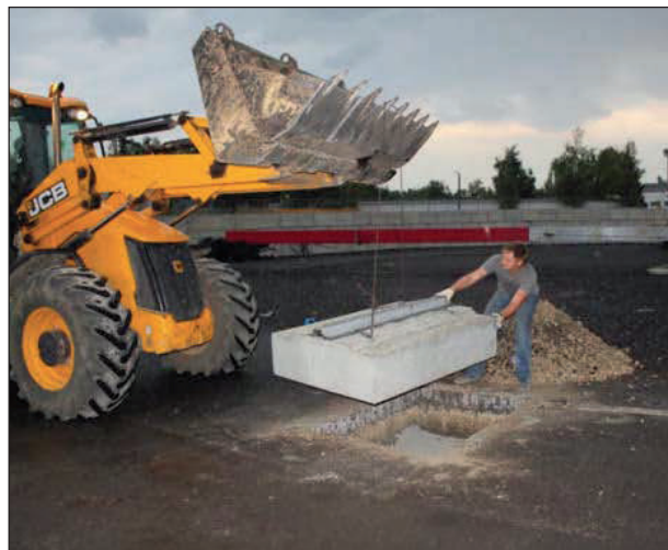
Рис. 5.5 Монтаж модели шва в проектное положение
