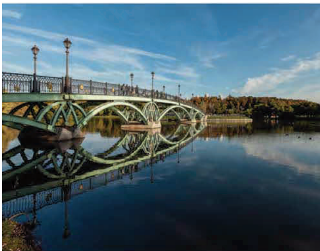
Локальный ремонт покрытия мостиков парка Царицыно, г. Москва
