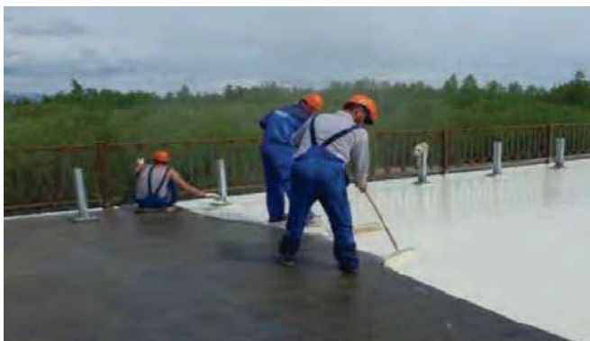
Нанесение гидроизолирующей мембраны
