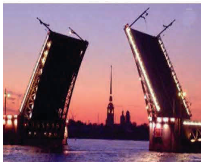
Устройство покрытия пешеходной зоны на разводном пролете, Дворцовый мост, Санкт-Петербург
