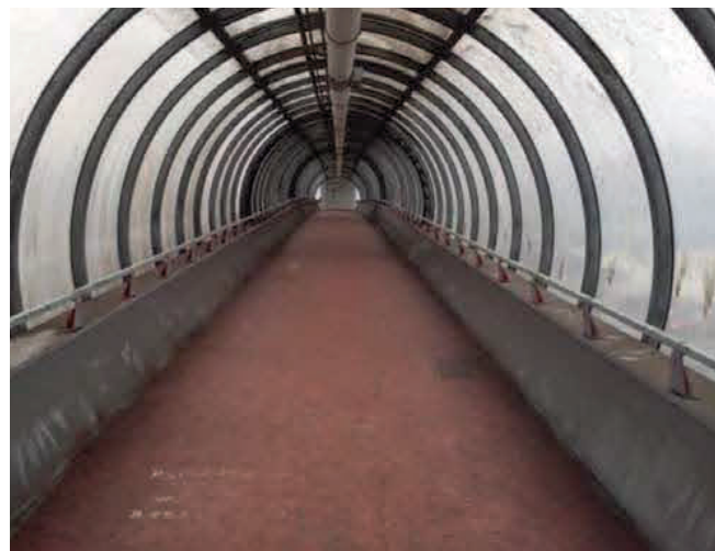
Устройство покрытия пешеходного моста, МКАД 89-й км, Москва
