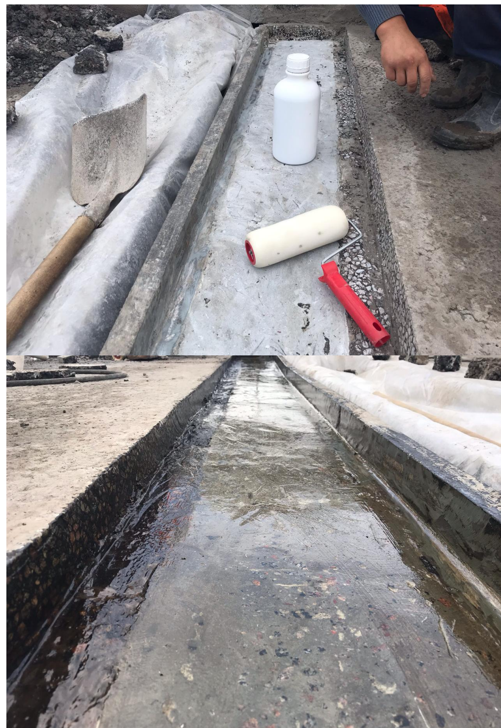
Грунтование очищенной штрабы праймером
