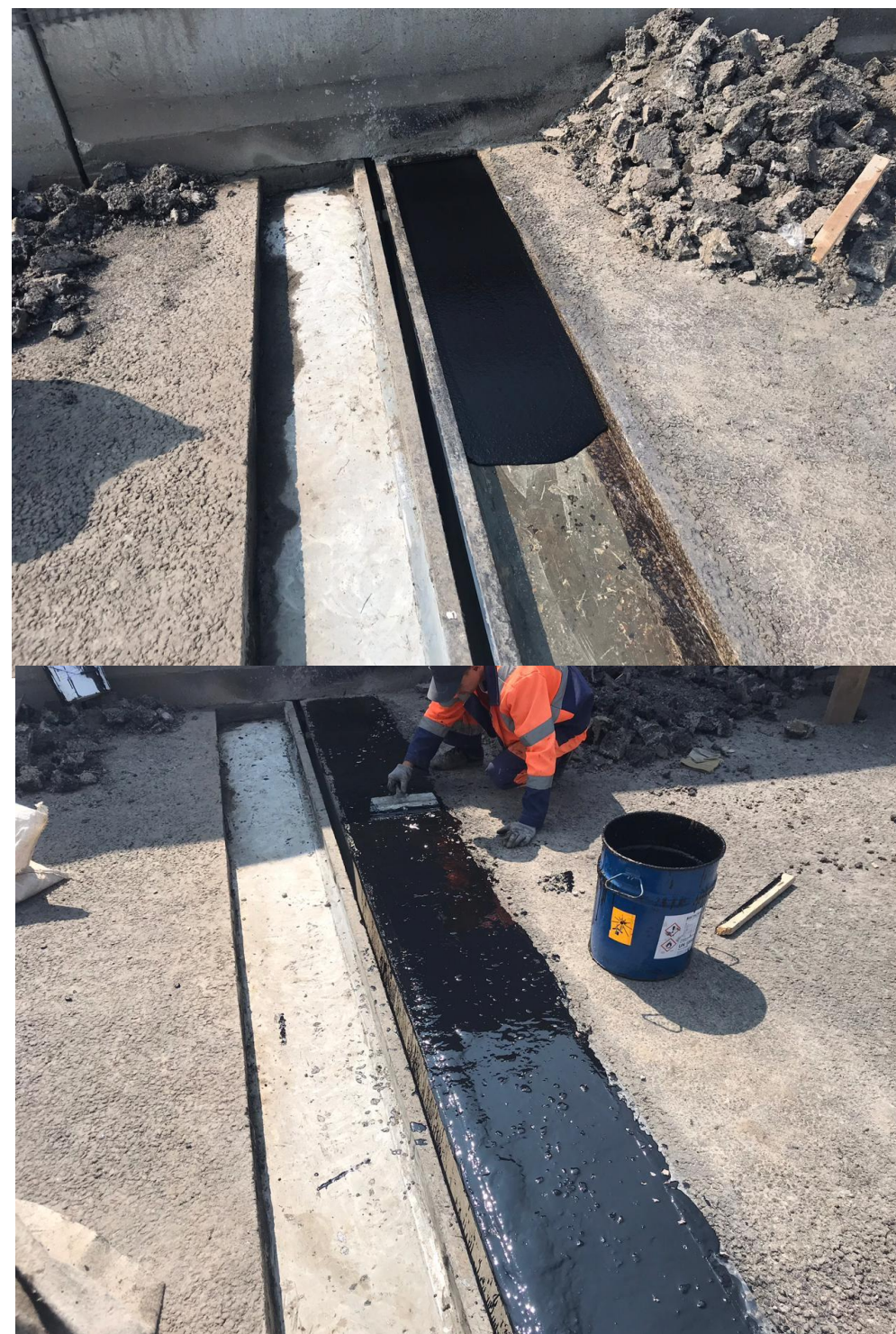
Устройство полимербетона Рабберфлекс ДШ 250
