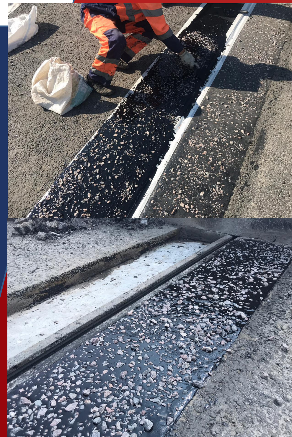
Устройство контакта- сцепляющий слоя
